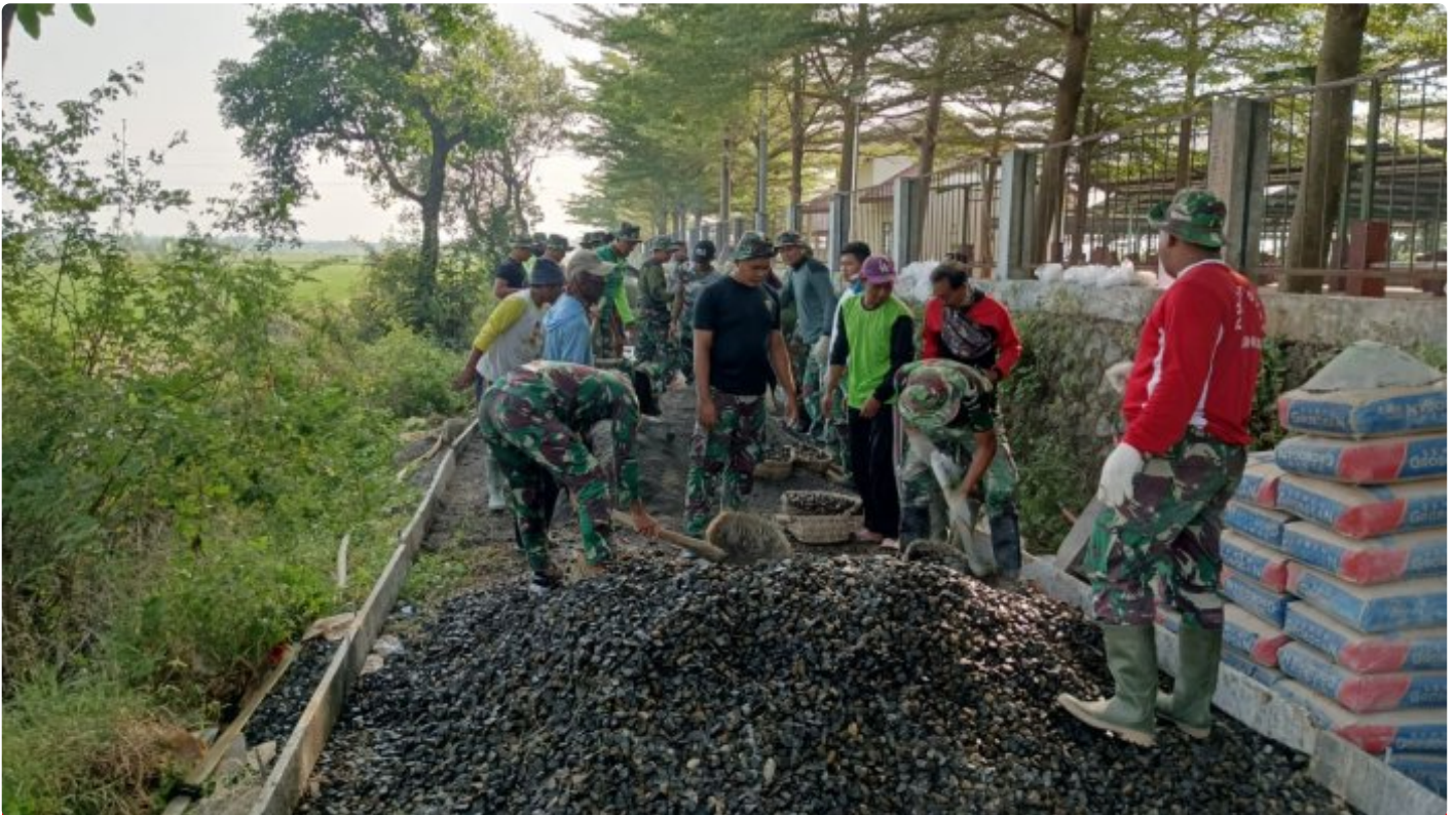
Foto istimewa ( Satgas tmmd reg 116 kebut pengecoran jalan
